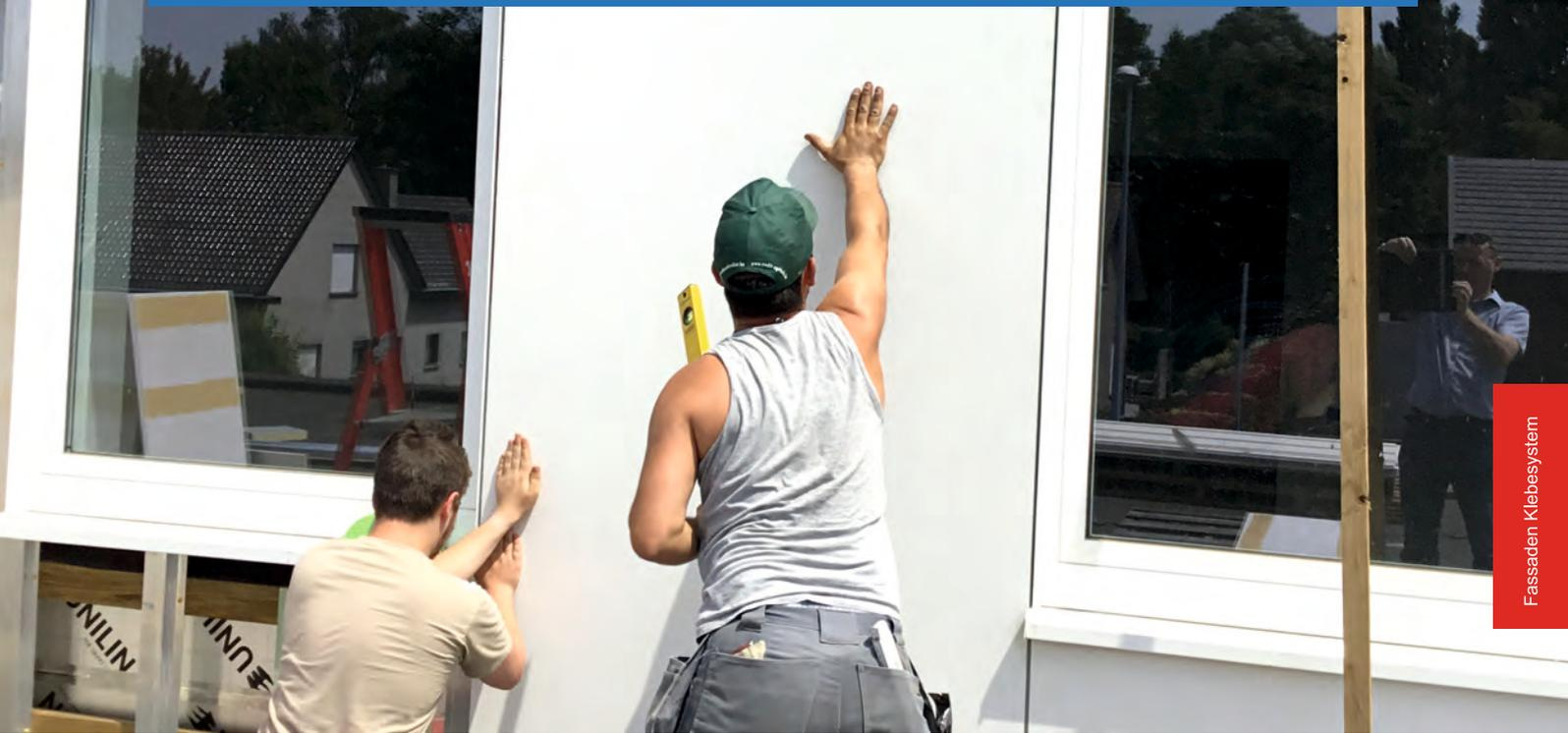
Die Fassadenplatten können sowohl im Werk als auch auf der Baustelle verklebt werden.
